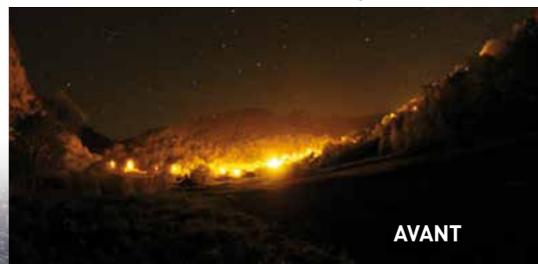
▼ Eclairage de la commune d'Aulon
