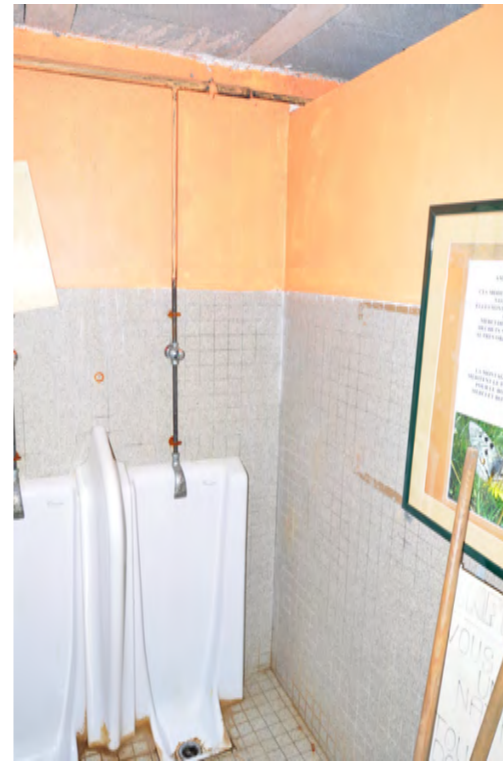
Les urinoirs à démolir
