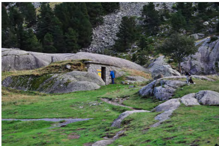
Toilettes existantes enchâssées entre deux massifs de granit
