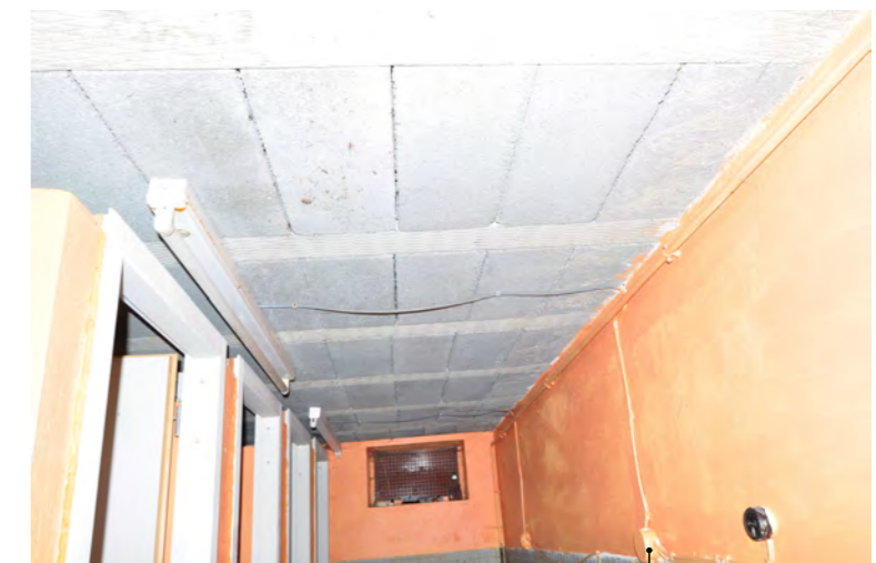
Point l'alimentation électricité
