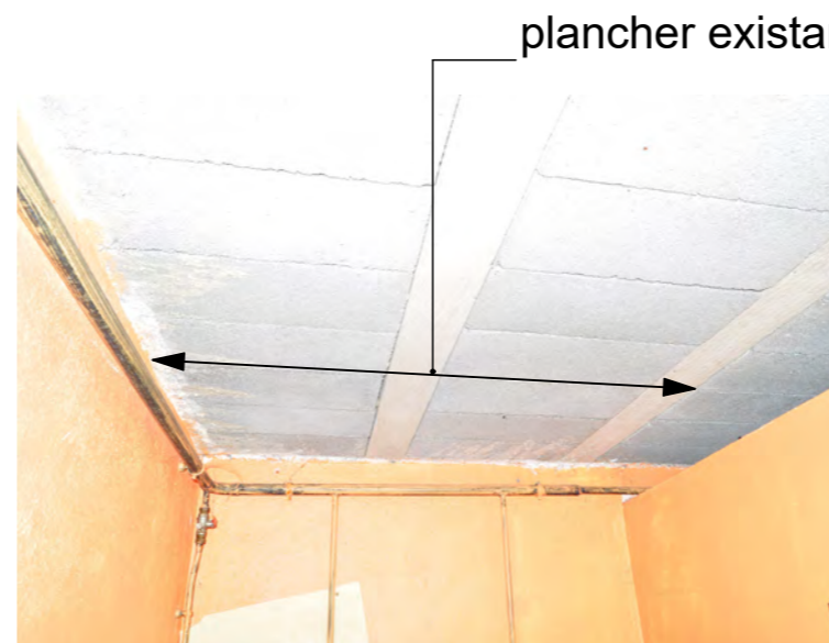
Vue du plancher hourdis
