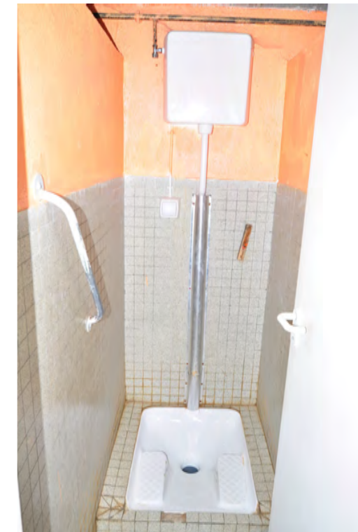
Les appareils sanitaires et socles à démolir dans chaque cabine
