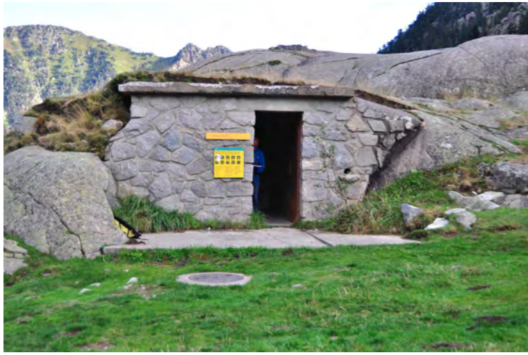
Façade SUD - toilettes existantes
