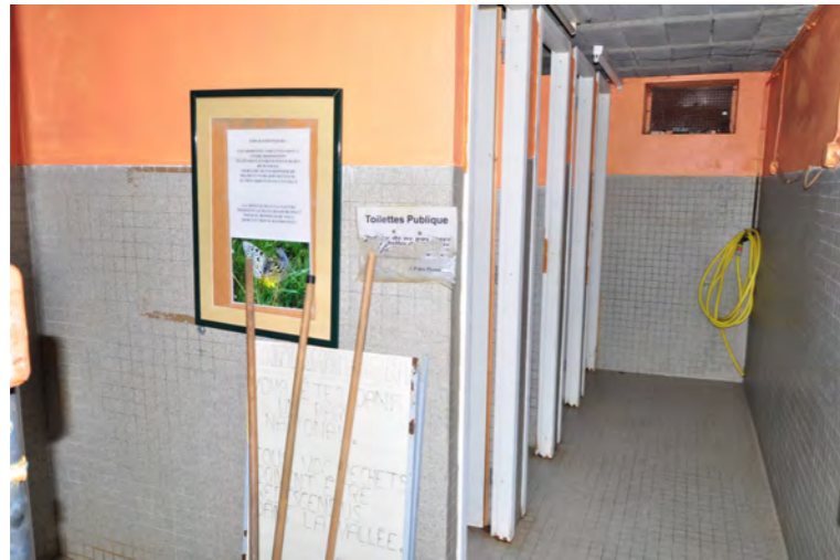
Les cabines à démolir
