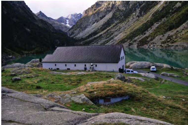
Toiture des toilettes, dalle béton recouverte de terre végétale
