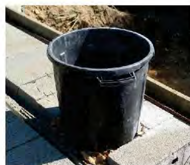
4 : Colonne de chute réalisée avec poubelle noire
