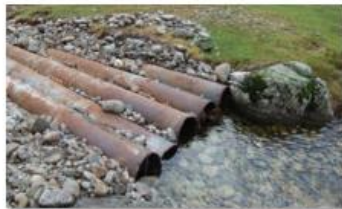
Réfection du pont, couverture des buses et reprises des têtes d'aqueduc par Espace Cauterets
