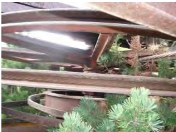
On distingue le câble entre les deux poulies qui part vers le pylône 7 - ravine de Cagohor - et le câble qui descend vers le pylône 9 dans la poulie inférieure.
