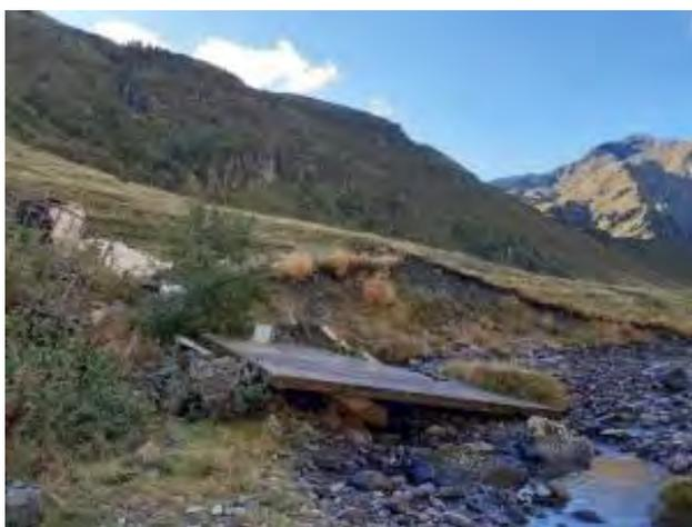
L'estimation des installations à démolir et évacuer est de 11 mètres cubes pour la dalle et de 13 mètres cubes pour les massifs beton et murs restant.
