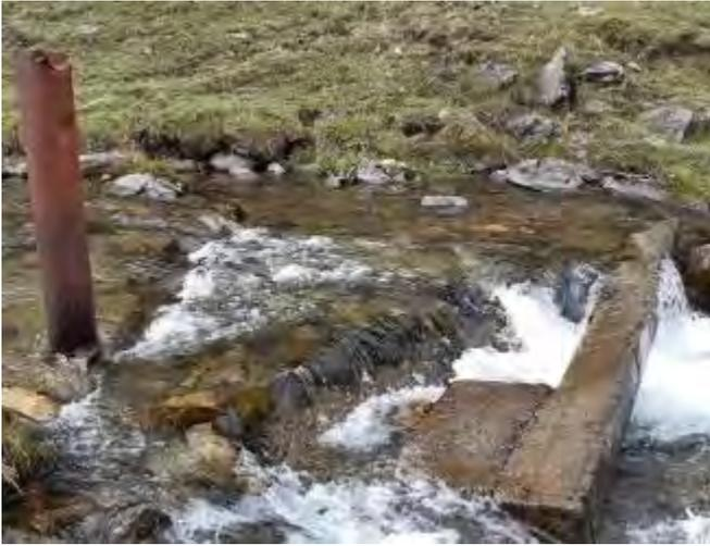
L'estimation des installations à démolir et évacuer est de 1 mètre cube pour le massif. Le tuyau en fer à démonter et évacuer a une dimension de 1,50 mètres de haut pour un diamètre de 2,25 mètres cubes.
