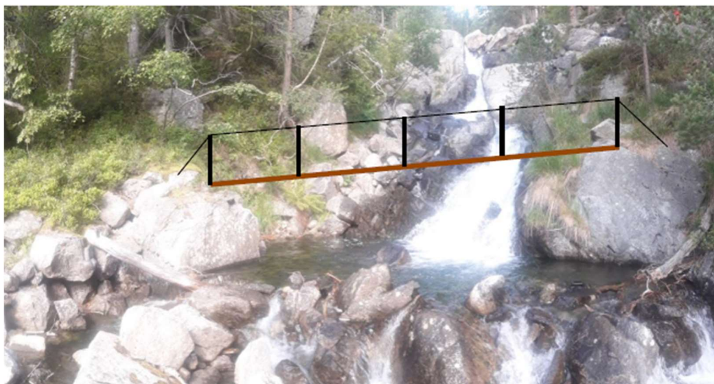
Photo de mise en situation sur site du franchissement
