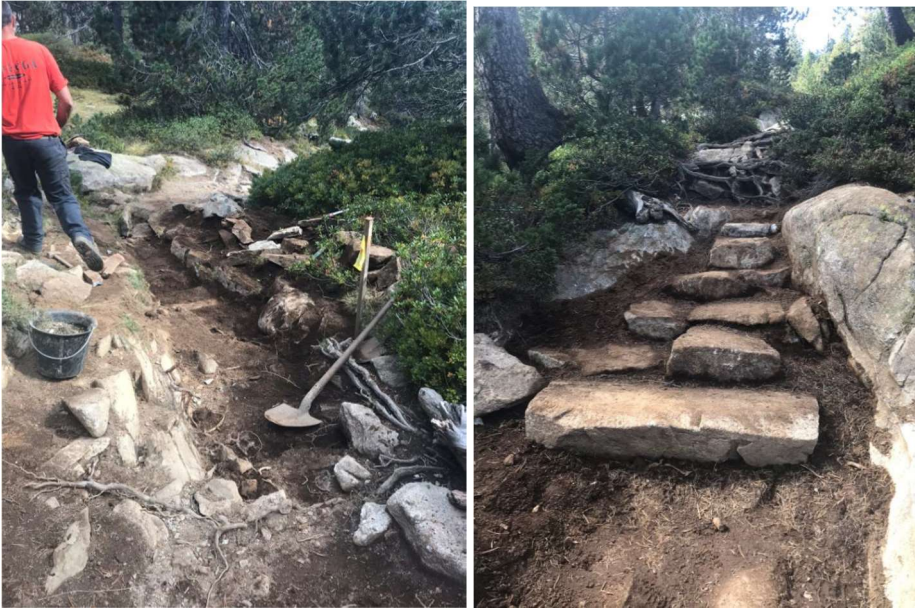
Photo exemple d'analogie : Travail de réfection du sentier des Laquettes (Parc National des Pyrénées) 2020 : travail manuel, emmarchement avec valorisation des matériaux en place, ou ponctuellement apport de matériaux par hélicoptage.
