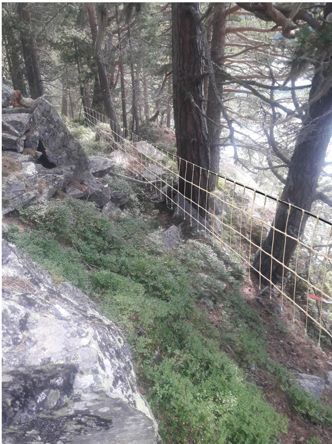
Garde-corps avec filet de corde (Photo et dessin : ONF)
