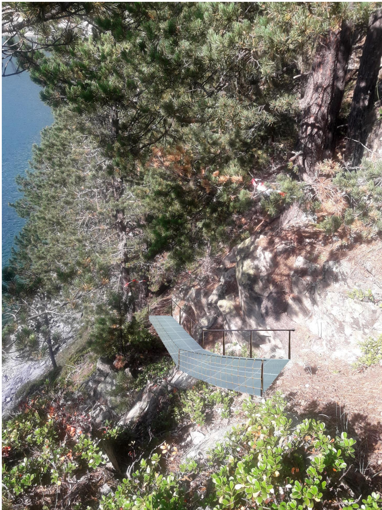
Escalier avec garde-corps en filet de corde. Photo et dessin : ONF
