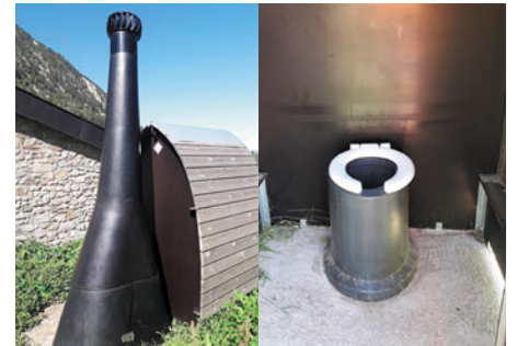
Dispositif à séparation des urines avec système de déshydratation des matières et séchage des urines par circulation d'air à l'intérieur du réservoir (Kazuba®).
