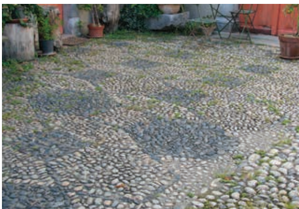
Calade mise en œuvre avec motifs géométriques. © C.A.U.E.65
