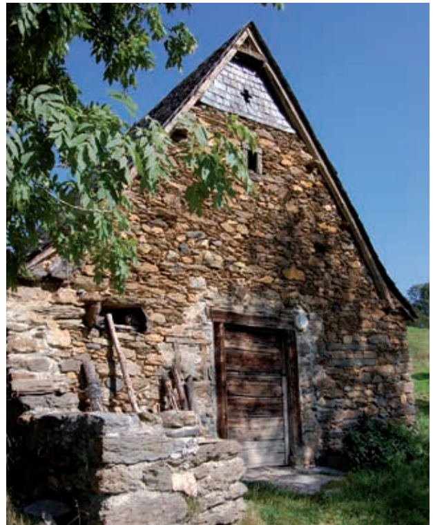
▲ Pignon de grange laissant apparaître une niche dans l'épaisseur du mur. © C.A.U.E.65
