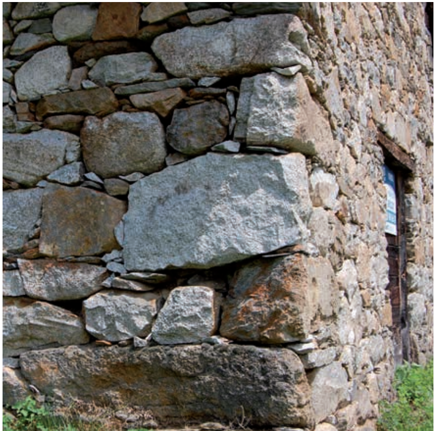
▲ Chaînage d'une grange. © C.A.U.E.65
