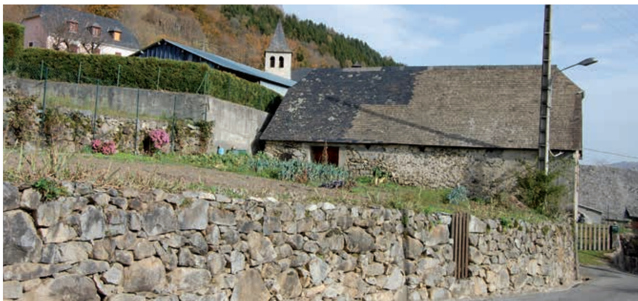
▲ Mur de soutènement le long de la route. © C.A.U.E.65
