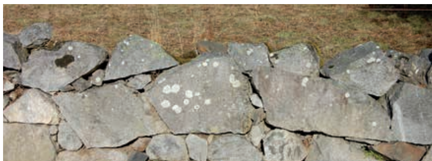
▲ Mur de soutènement. © C.A.U.E.65
