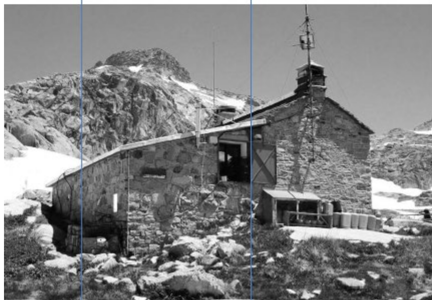
Partie construite en 1966
