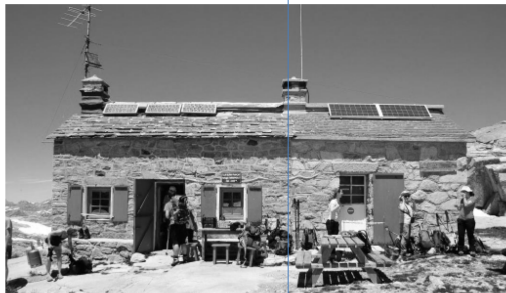
Partie construite en 1926
