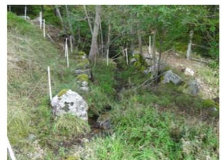
À l'amont de la grange foraine (à gauche), une source est captée par le biais d'une rigole parallèle à la pente. Près de la grange (au centre), la rigole est canalisée par des blocs de soutènement empruntés à la moraine. Plus à l'aval (à droite), l'exutoire conduit l'eau au centre du quartier.
