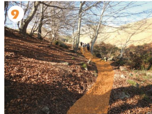
Début du sentier qui doit être recalibré à plusieurs endroits, l'assiette fait environ 1 m
