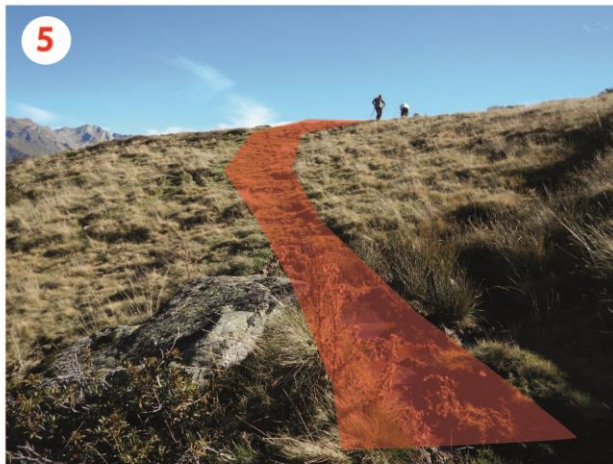
Partie à décaisser sur 20 mètre
