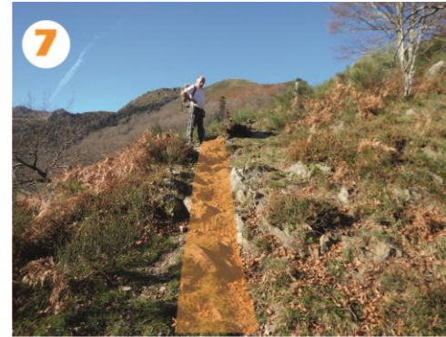
Début du sentier qui doit être recalibré à plusieurs endroits, l'assiette fait environ 1 m
