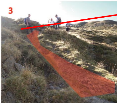
Partie à décaisser sur 20 mètre
