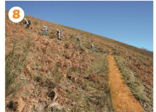
Début du sentier qui doit être recalibré à plusieurs endroits, l'assiette fait environ 1 m
