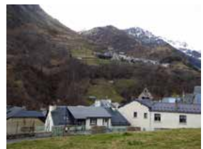
Partie ouest du village
